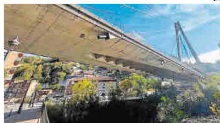
El puente atirantado del Corredor del Nalón a su paso por Sama.
